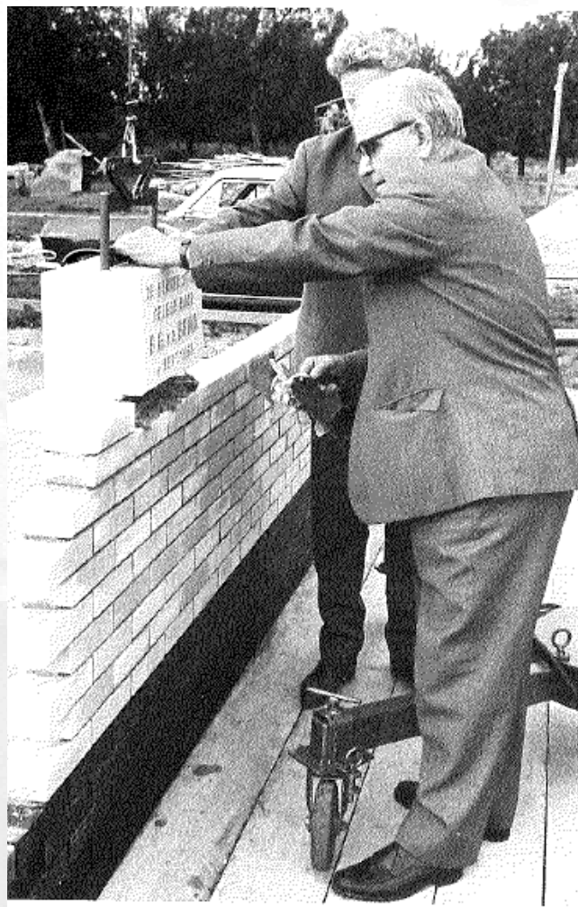
Eerste steen bouw RCK laboratorium (H.A.M. Ultée, 1997)
