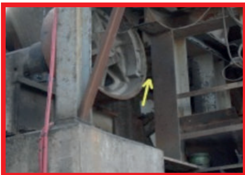
Dodelijk ongeval in de groep – casestudy 2006: Tijdens hijswerkzaamheden raakte een supervisor geklemd tussen de last en een stalen balk.
