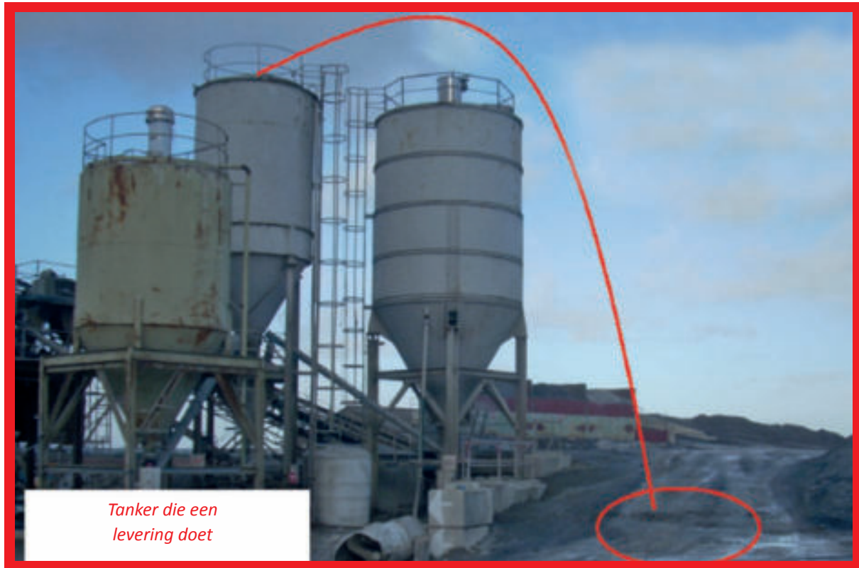
Incident – bijna-ongeval 2019: Filter uitgeworpen tot in een nabijgelegen gebied
