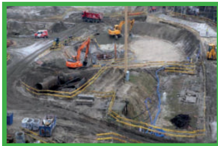
Transportsystemen op een bouwterrein.
