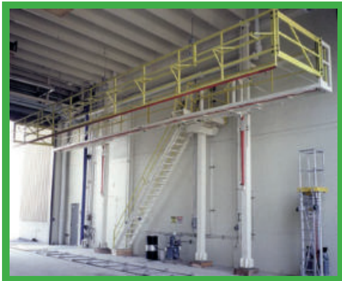
Systeem bij Finnsementti om de tankchauffeur te beschermen tijdens het laden. De lengte en hoogte van dit systeem moet worden aangepast om te passen op alle voertuigen.
