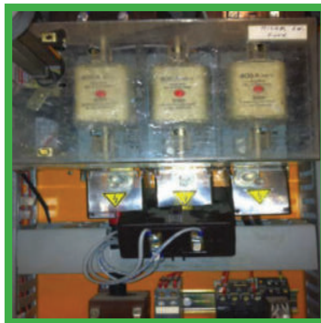
Alle aanraakpunten onder spanning omhuld en bedekt.
