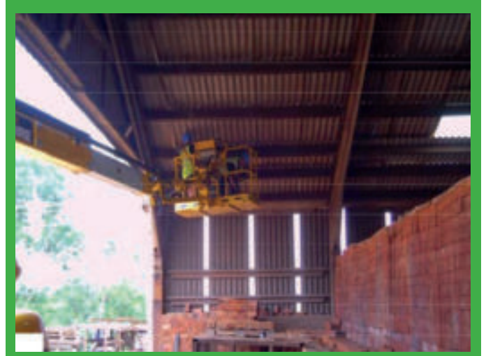
Hoogwerker aan het werk in een steen- en cementfabriek.
