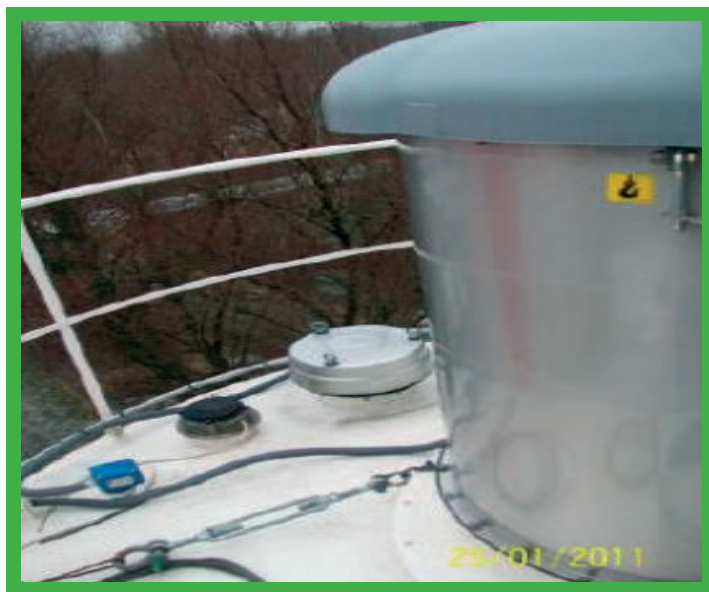
Laatste redmiddel: Filter vastgeketend aan de behuizing van de silo.
