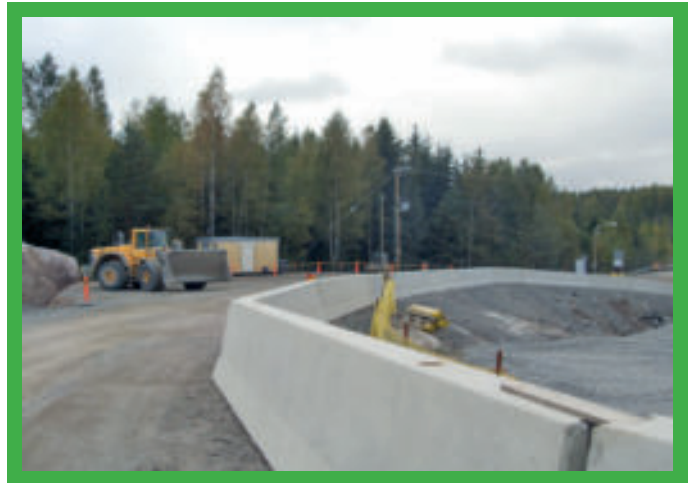
Randbescherming met prefab constructies.
