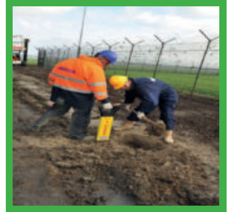
Controle op de aanwezigheid van ondergrondse leidingen alvorens een omheining op te trekken.
