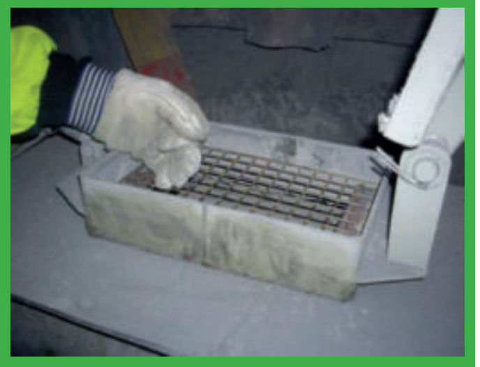
Inspectieluik (met beveiligd rooster) op een schroeftransportband.
