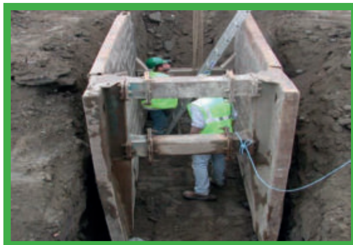
Boxbekisting in gebruik.
