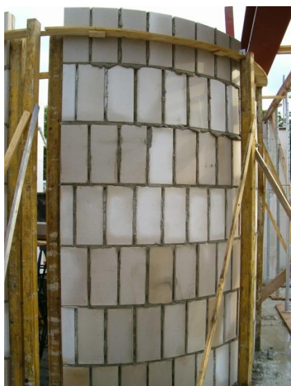
Verticaal vermetselde lijmblokken.
