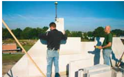
Kalkzandsteen lijmbedrijf Moorland bv heeft slechts een ochtend nodig om beide topwanden op de woning te zetten. Op de elementen is de codering te zien, die de uiteindelijke plaats aangeeft.
