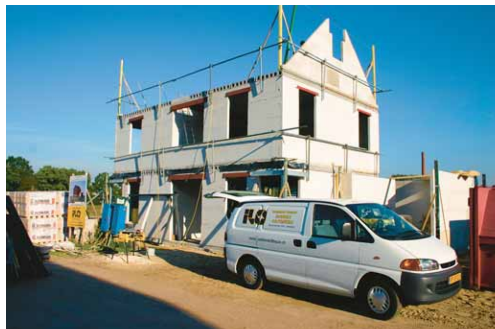
Aannemersbedrijf Robbert Oosterveld is overgestapt naar een bouwsysteem met kalkzandsteenelementen om beter in de markt te kunnen concurreren.
