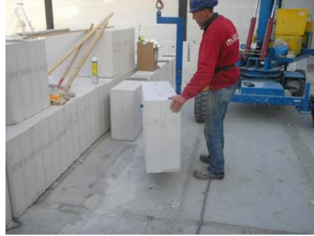
Stap 2: het oppakken van de elementen, let hierbij op de borging van het element!
