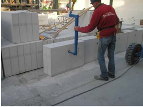
Stap 2: het oppakken van de elementen, let hierbij op de borging van het element!
