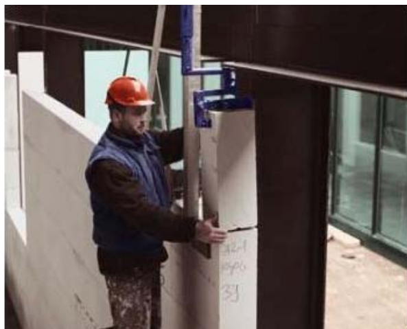
C-beugel met de elementenklem en de passtukkenklem
