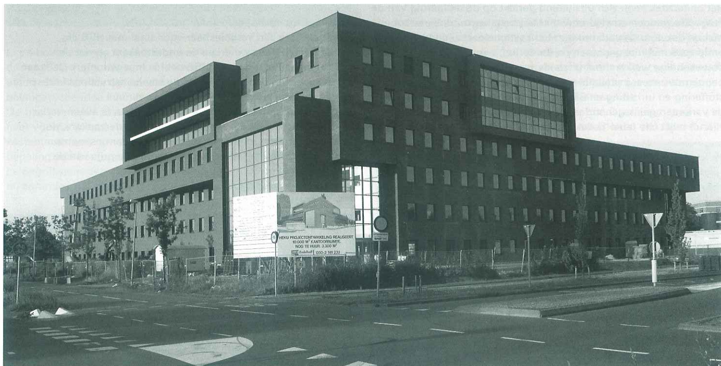
Het kantoorpand van VCD in Groningen, met 6 bouwlagen, heeft een kalkzandsteen casco
