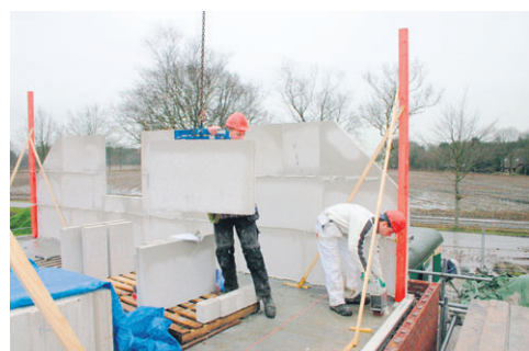
Theo Boer (rechts) van Bouwbedrijf Moes verlijmt de elementen. Collega Arjan Vredeveld bedient de 10-tonmeterkraan.
