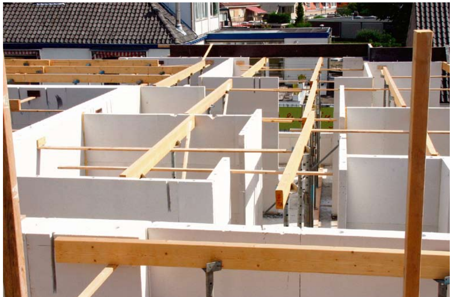
Overzicht van het project. Let op de sleuven die vast in de bovenzijde van de wanden zijn gefreesd. Dat voorkomt problemen met het zagen wanneer de vloer er al opligt.
