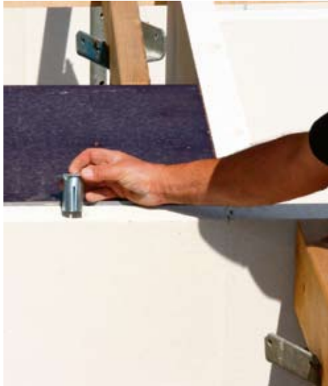
Plaatsing van een ankerplaatje in een dookgat, voor de verankering van de vloer aan de wand.
