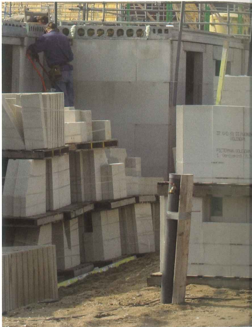
Dezelfde Calduran kalkzandsteenelementen voor wanden en muren zijn ook bruikbaar in de fundering.
